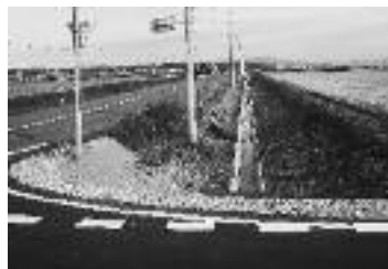
町道南2条路線側溝・路肩改修 6683万円（土木費）
