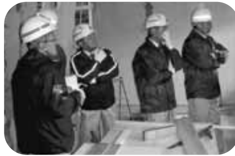
旭A団地新築工事現場
